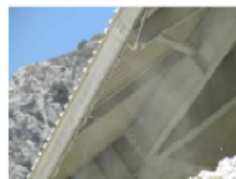
Gardiande d'aspersion autour du chapiteau
