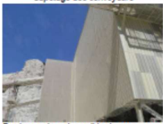
Bardage autour des unités de concassage
